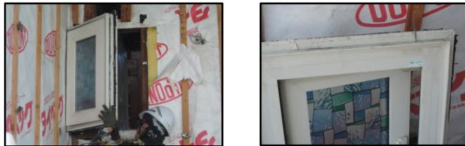
3 枠・障子の取り外し
