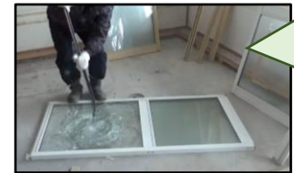
障子の解体・ガラスの除去
