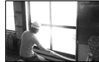
枠の取り外し
