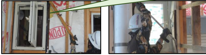
1 額縁・周辺部材の撤去
